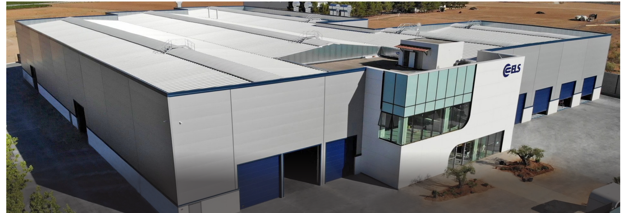
ELS Aviation manufacturing plant. Tomelloso, Spain.
